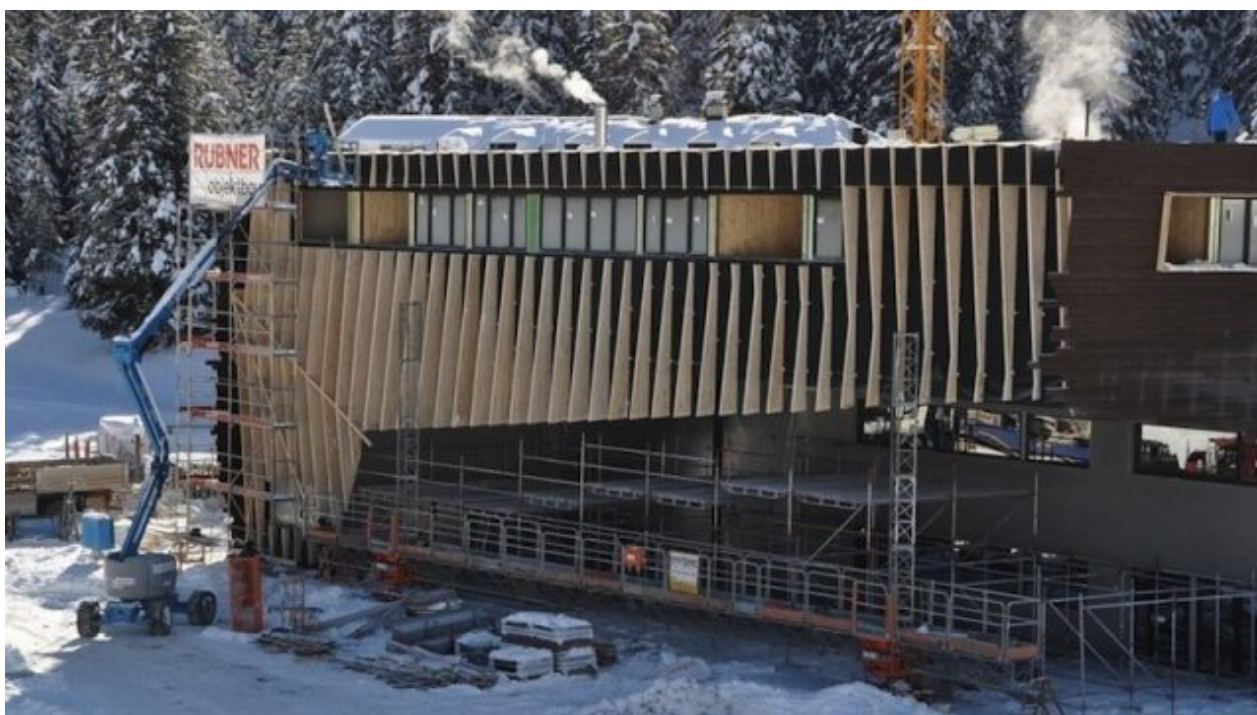
La cabinovia in fase di costruzione
